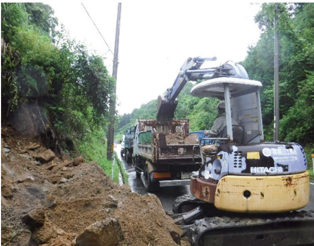
▲▼重機を用いて道路への土砂崩落を応急復旧する様子▼▲
