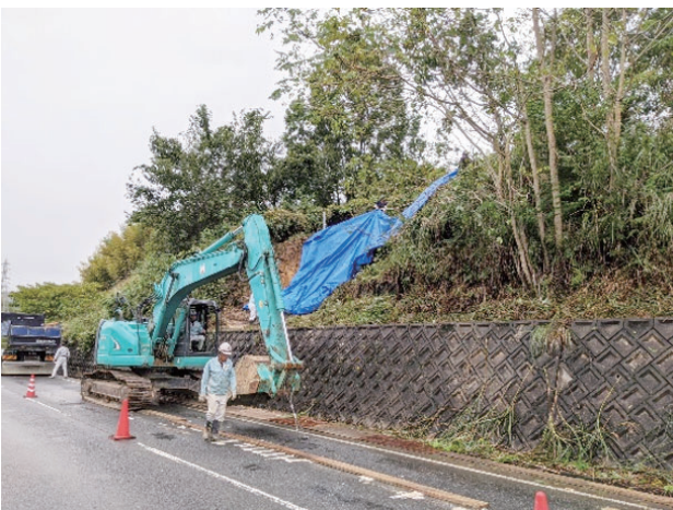
▲▼重機を用いて道路への土砂崩落を応急復旧する様子▼▲
