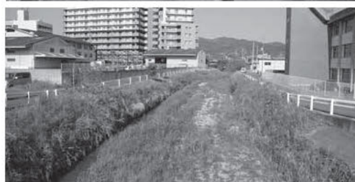
布留川の護岸工事直後（上）／現在（下）
