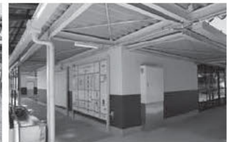
耐震補強された渡り廊下屋根
