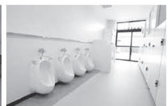
改修されたトイレ
