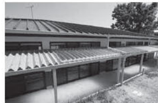
再塗装された屋根
