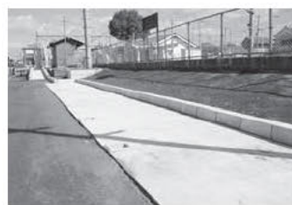
新設される駐輪場
