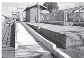
出入口南側スロープ
