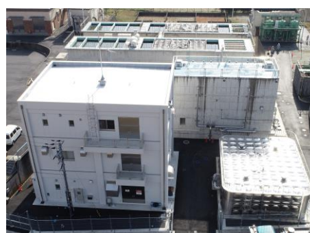
杣之内浄水場
