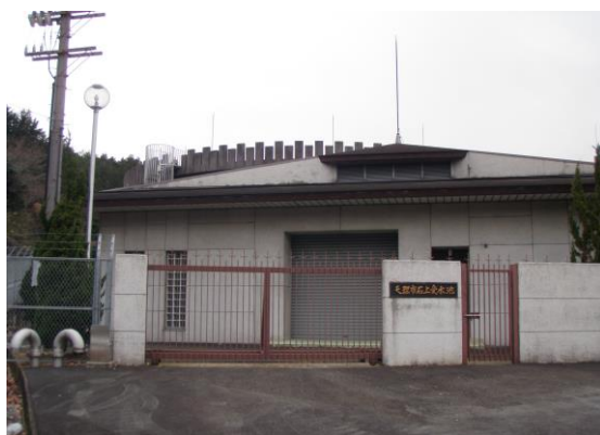
石上北県水受水池
