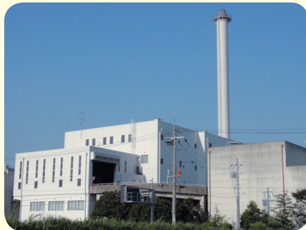
天理市環境クリーンセンター
