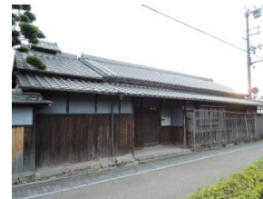
空き家の活用
