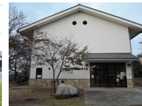
既存施設の活用
