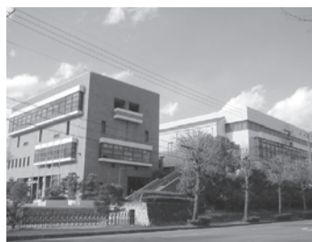
改修中の市立総合体育館
