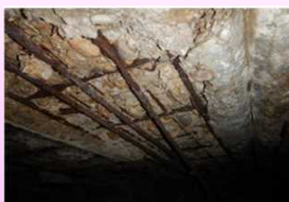
主桁の損傷（鉄筋露出）
