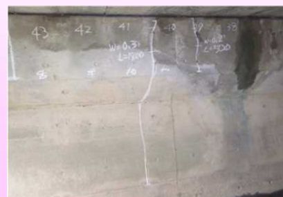
橋台の損傷（ひびわれ）
