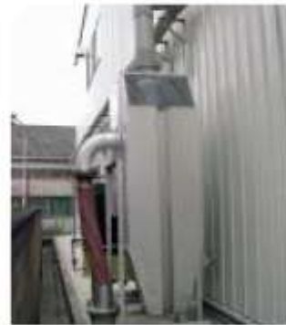
▲地下タンクに雨水貯留
