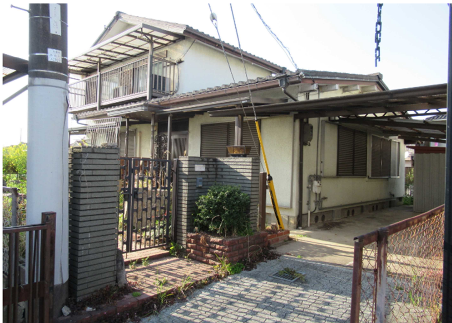
現況写真 天理市東井戸堂町4 6 6 番地9 土地・家屋
