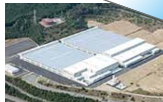
▲第一期工事を終えた三甲(株)関西第3工場
