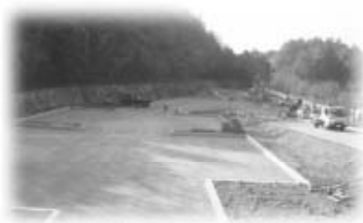
二期工事 駐車場整備
