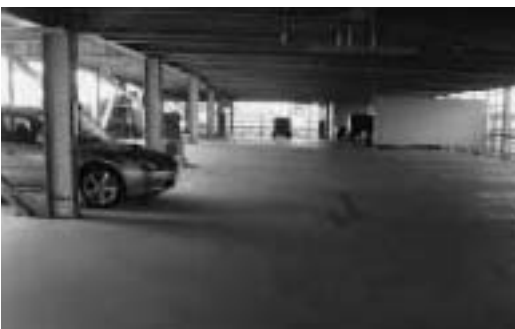
駅前立体駐車場（3階）
